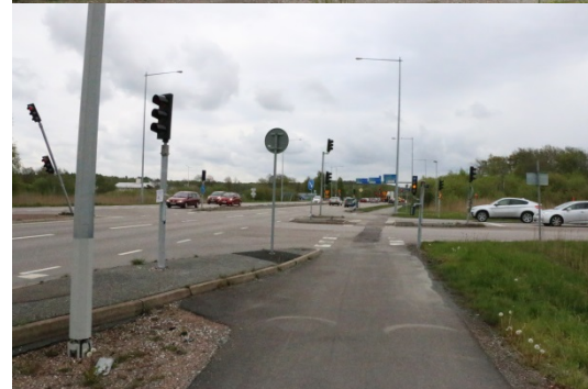
Figur 4 Kongahällavägen vid Låssbyvägen, Björlandavägen mot Hisingsleden.
